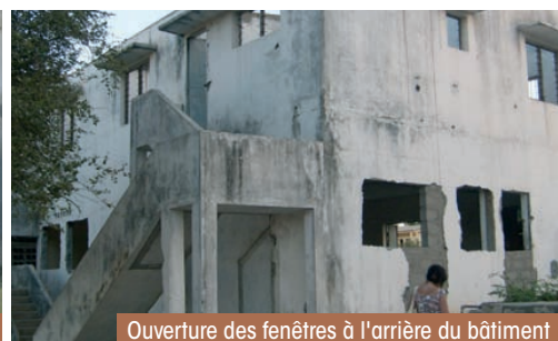
Ouverture des fenêtres à l'arrière du bâtiment
