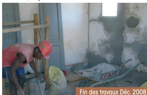
Fin des travaux Déc. 2008
